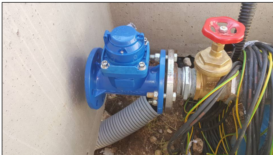
fotografia 3: dettaglio dell'attrezzatura della testa del pozzo.
