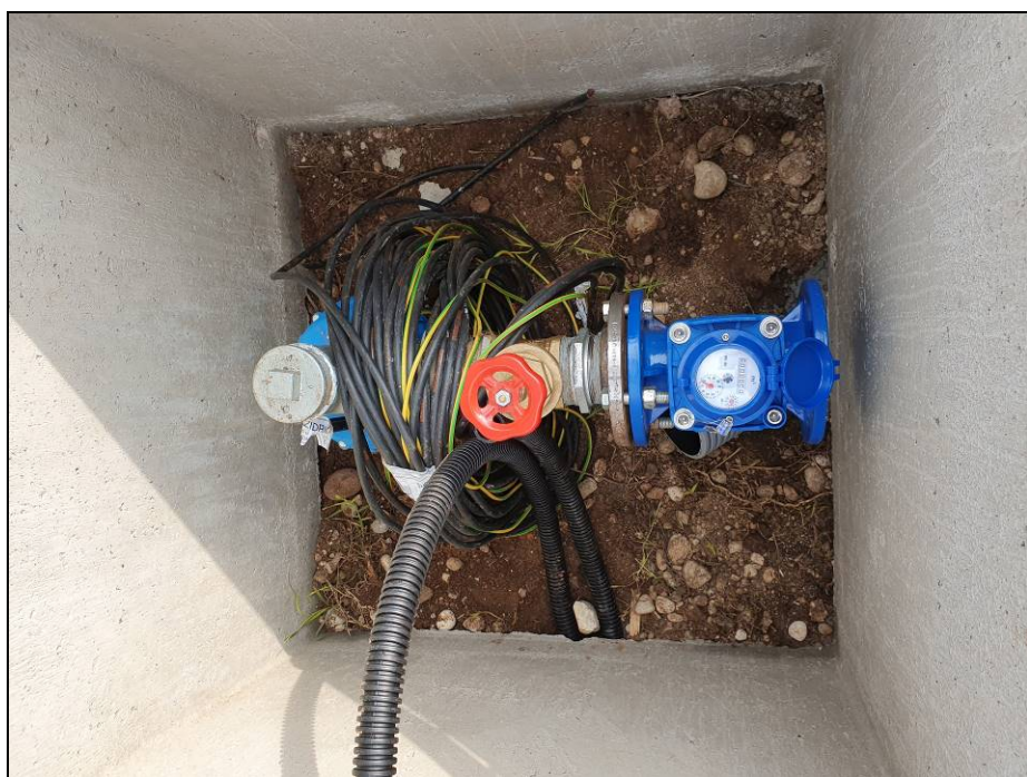
fotografia 4: dettaglio dell'attrezzatura della testa del pozzo.
